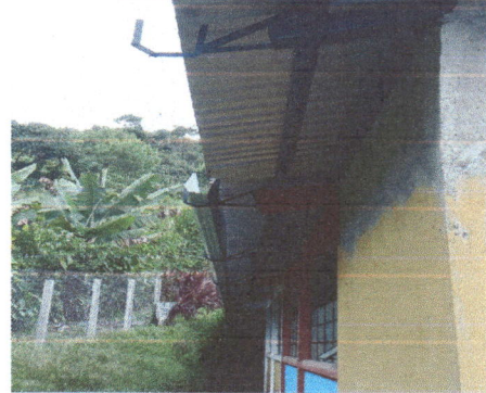
Foto 8: Se observa cambio de canales con pescantes y dos bajadas de agua fluvial area de atrás
