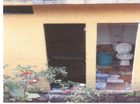
Foto 4: Se observa el cambio de dos puertas de metal 0.8*2.10 en sanitarios
