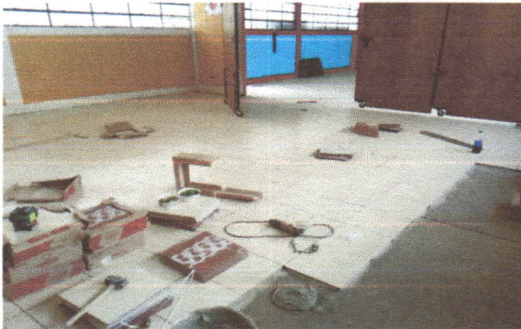
Foto 5: Se observa el cambio de piso ceramico Samboro en dos aulas y direccion en formato de 0.31*0.31 mts
