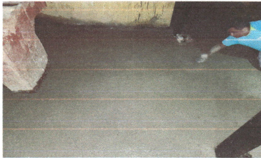
Foto 9: Se observa el cambio de base de concreto de 0.05 mts de grosor en area de pila y baños
