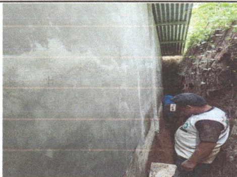
Foto 11: Se observa mantenimiento de muro de aula con excavacion, lavado, alisado impermeabilizado y sellado
