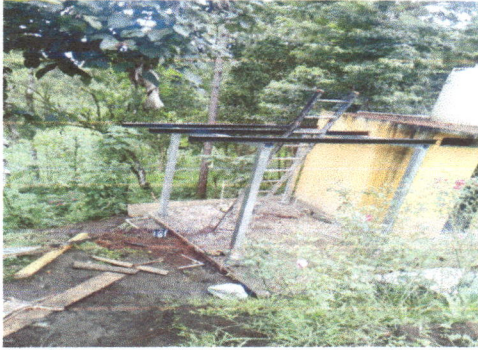
Foto 1: Se observar el proceso para el cambio de cubierta de lamina troquelada calibre 26 en dos ambientes pila y direccion
