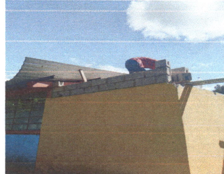
Foto 10: Se observa levantado de muro de block de piedra 0.20*0.40*0.15 clase B para nivelar la pared de direccion
