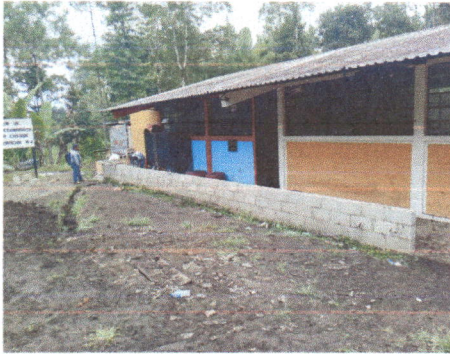
Foto 7: Se observa el cambio de canales y bajadas de agua fluvial de enfrente
